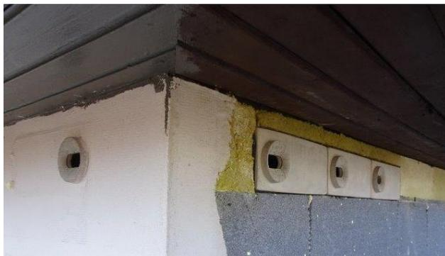
An einer anderen Baustelle der NH wurde der Mauersegler WDV-Einbaukasten Typ 1A in die Dämmung eingesetzt.
