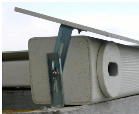
Auf die Beton-Brüstung befestigten wir mit Edelstahl-Schrauben 2 Schwegler-Kästen Nr. 17A-3fach. Zusätzlich bekamen die Nistkästen ein Dach aus 9mm wetterfester Sieb-Druckplatte, weiß gestrichen als Sonnen- und Wetterschutz.
