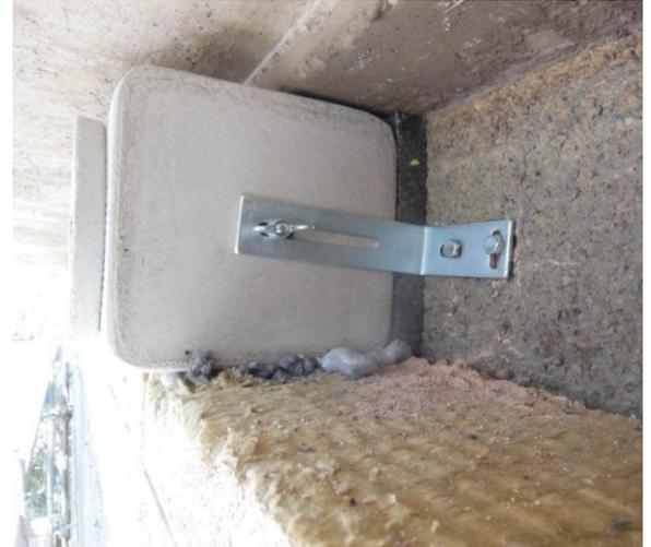
*hier wurde noch zwischen Wand und Kasten eine dünne, hochwirksame, Dämmplatte gesetzt. Dadurch stand der Kasten ca. 2cm aus der Putzwand raus. Die 15cm tiefen Kästen können aber auch voll in die Dämmung eingeschäumt werden, dass nur noch die runde Einflug-Rosette zu sehen ist.*
