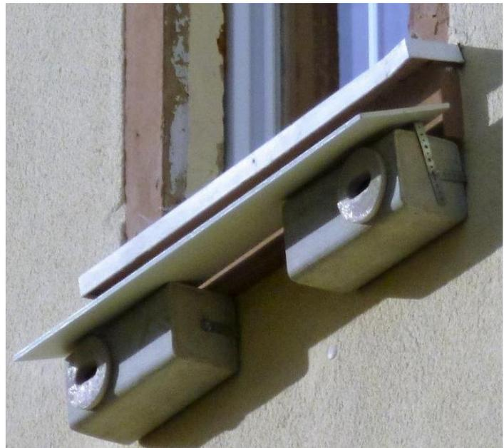
Vom Fenster aus, montierten wir 2x2 Schwegler Nr. 17 unter die Fenster. Zusätzlich auch ein Dach als Sonnen- und Anflugschutz, aus 9mm wetterfester Siebdruckplatte. (an dem Haus nisteten bereits Mauersegler unter den Dachziegeln am Ortgang)
